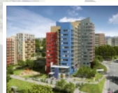
Bytové domy Bohdalec etapa II.
